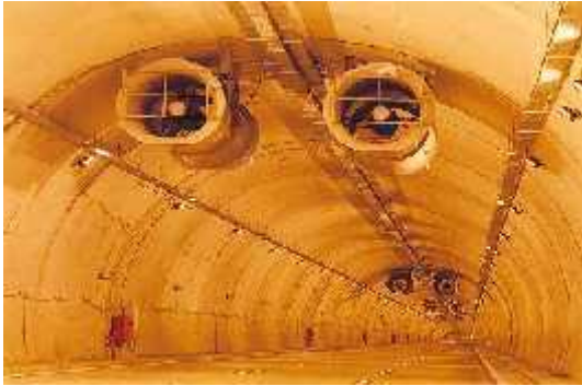
Figura 1 - Sistema de ventilação longitudinal
