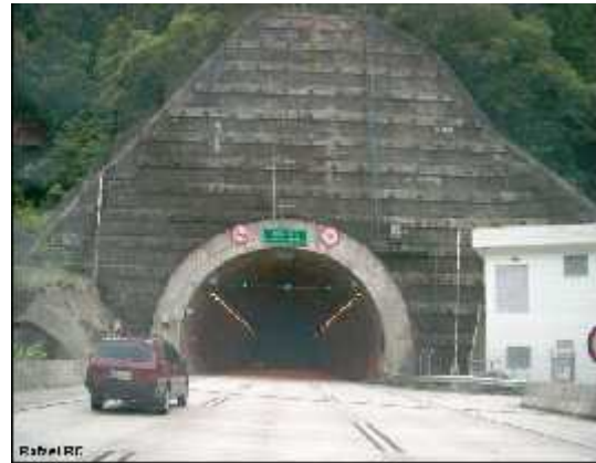
Figura 2 - Sinalização na entrada do túnel
